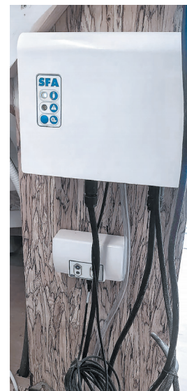
Le panneau de contrôle de la Sanicubic 1 est muni d'une alarme visuelle et sonore (avec 15 pi de filage).
